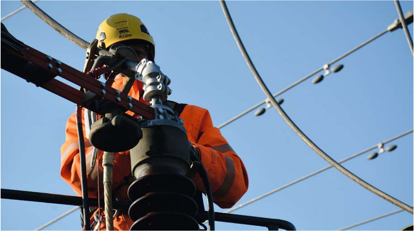
Die Leiteranschlussklemme aus dem 3D-Drucker wurde im Unterwerk Gry-nau der Axpo eingebaut.
