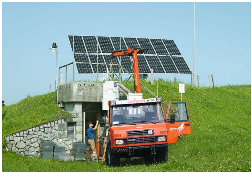
Die Anlieferung der SF 6 -freien Schaltanlage bei der unterirdischen Trafostation auf 1600 M.ü.m.
