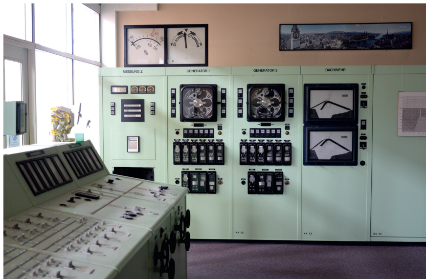
Operational Technology ohne Risiko einer Cyberattacke: Bis 2003 wurde hier das Kraftwerk gesteuert, die Generatoren synchronisiert und die Wassermenge des Wehres manuell eingestellt.
