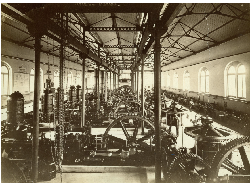
1880: Blick in den Maschinenraum. Die Jonvalturbinen von Escher Wyss trieben eine Transmissionswelle an, die fünf Pumpen antrieb und mechanische Energie lieferte.
