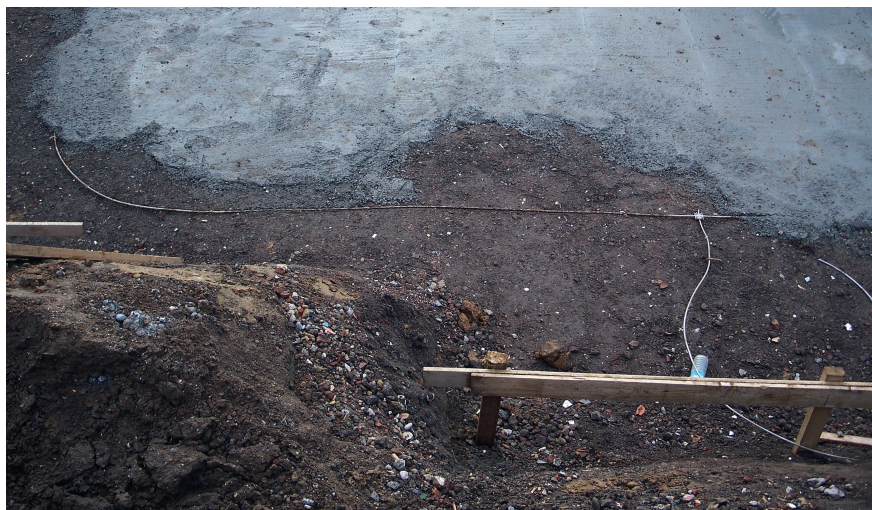
Innerer Blitzschutz: Fundamenterder in der Baugrube eines Einfamilienhauses.
