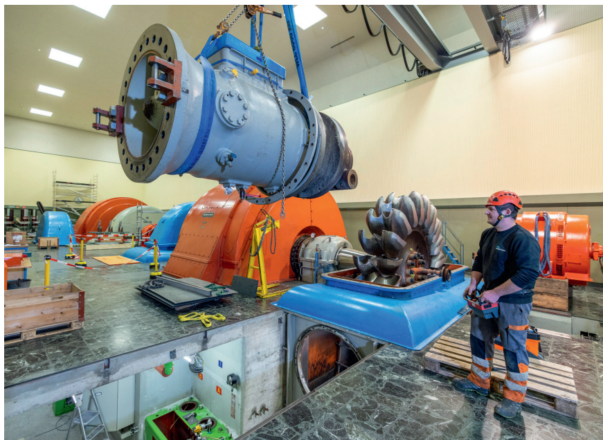
Demontage des alten Einlaufs an einer der Trift-Maschinen.
