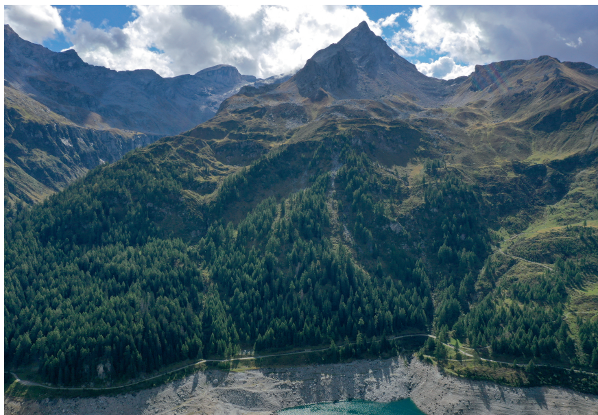
Cette photo prise par un drone montre, au centre, le versant rampant Marsc, près du lac de retenue du barrage de Luzzone, qui a été étudié à titre d'exemple dans le projet de recherche de l'ETHZ.
