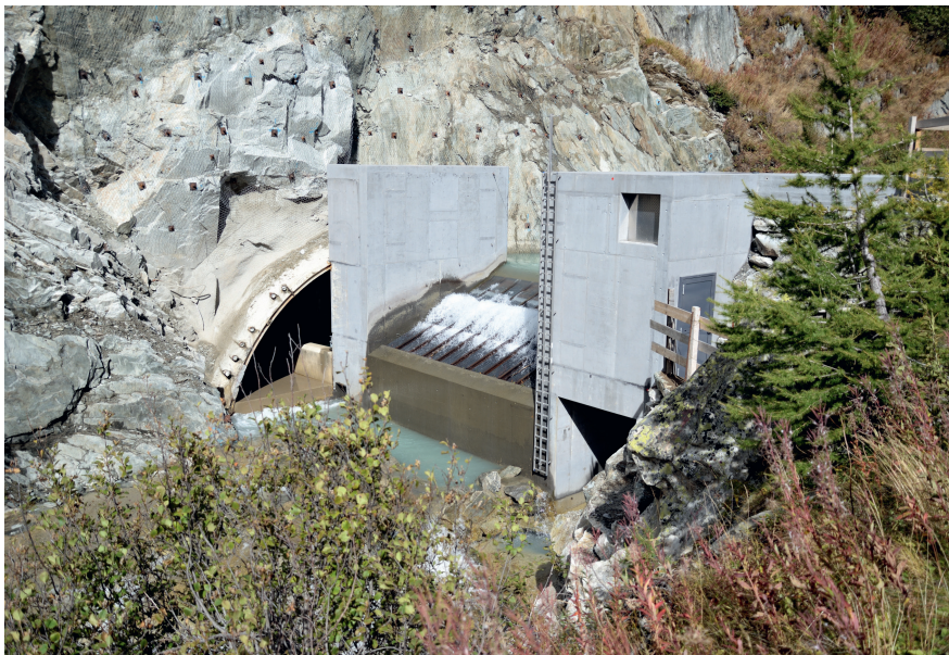
Prise d'eau en haute montagne de la centrale hydroélectrique de Gletsch-Oberwald. Cette centrale constitue un bon exemple de consensus combinant production d'énergie hydraulique et mesures environnementales de compensation : grâce aux mesures prises en matière de revitalisation, le Rhône a retrouvé, à Oberwald, son caractère original.
