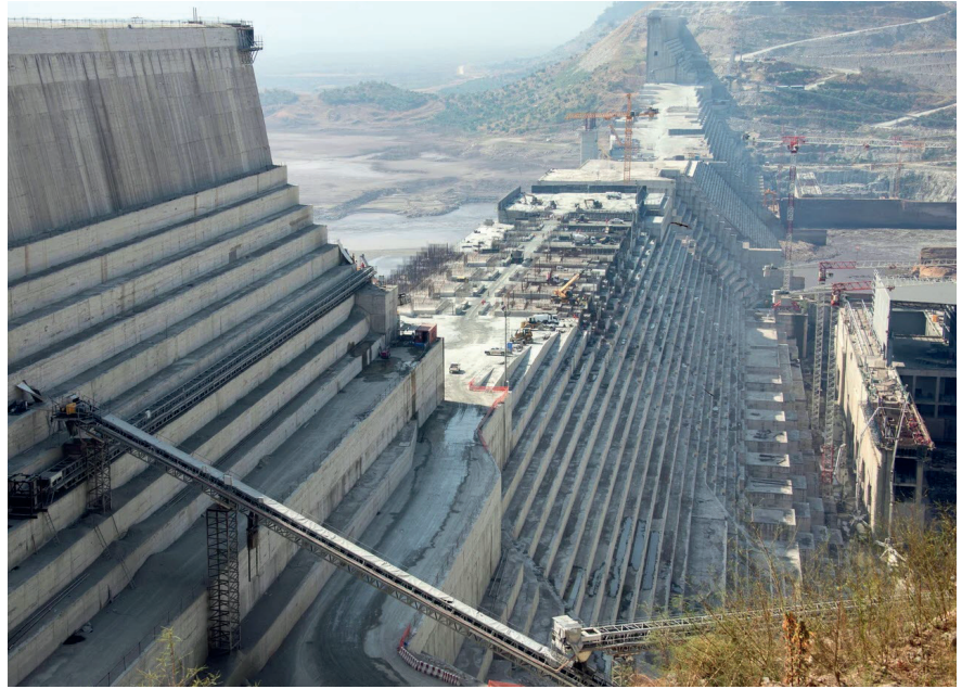
Le grand barrage de la Renaissance, en construction depuis 2011 en Éthiopie, comprend un barrage-poids d'environ 2 km de long et de 145 m de haut. Sa construction devrait être achevée d'ici 2028.
